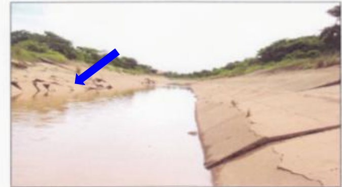
สภาพคอนกรีตแตกกร้าวและเดือนทรุดช่วง กม. 12+011 (ฝั่งซ้าย, ขวา)
