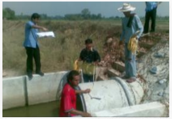
ตรวจสอบขนาดของอาคารฯ , ความหนา
