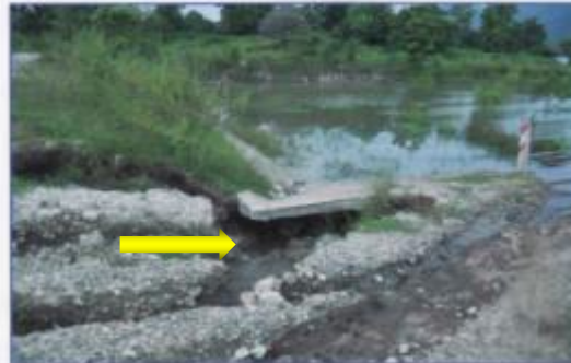
ภาพถ่ายบริเวณพื้นที่ก่อสร้าง คอนกรีตระบบน้ำประปา (งานที่ 2)
