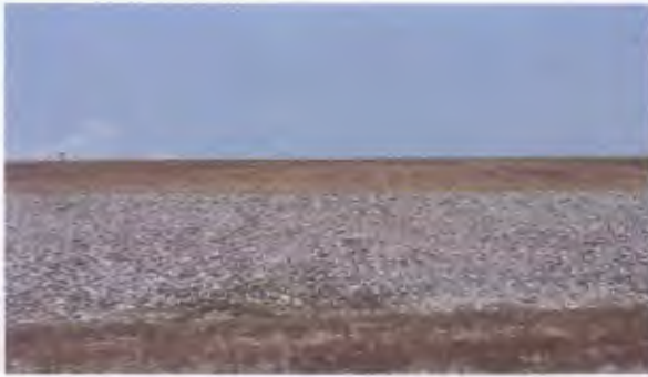
Rockfill Toe เขื่อนลำปาว จังหวัดกาฬสินธุ์
