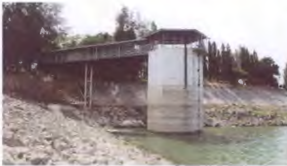
อาคารคอนกรีต เขื่อนลำตะคอง จังหวัดนครราชสีมา
