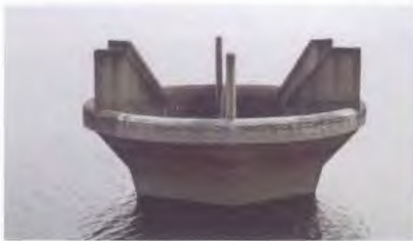
ภาพที่ 33 ส่วนควบคุมน้ำ อาคารระบายน้ำล้น
