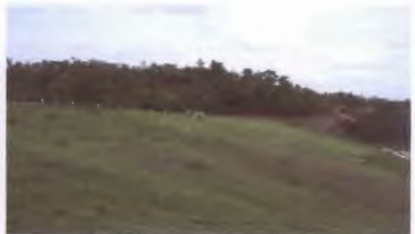
เขื่อนแม่ประจักษ์ จังหวัดเชียงใหม่ มี Rockfill Toe
