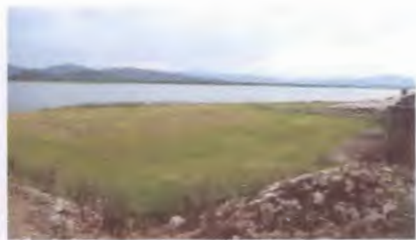
ส่วนทางน้ำเข้า เขื่อนทับเสลา จังหวัดอุทัยธานี
