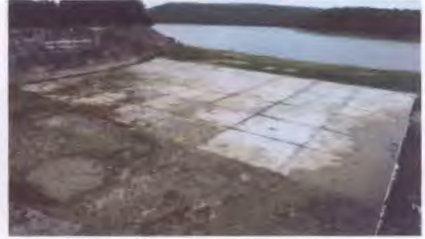
ภาพที่ 32 ส่วนทางน้ำเข้า อาคารระบายน้ำล้น
