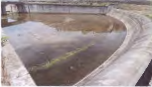
ฝายคอนกรีต พื่น และกำแพง เขื่อนแม่กวงอุดมธารา จังหวัดเชียงใหม่
