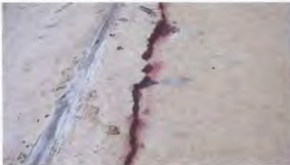
ระดับ 2 เกิดรอยร้าวมีความกว้างและความลึกเป็นทางยาว
