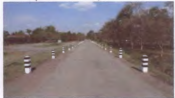
ฐานยันเขื่อนแบบไม่เห็นไหล่เขา เขื่อนหัวยลหลวง จังหวัดอุดรธานี
