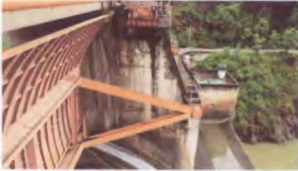
กั้นบาน และสลิง เขื่อนกัวลม จังหวัดลำปาง
