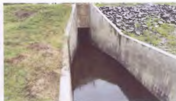
ภาพที่ 29 ส่วนทางน้ำออก อาคารท่อส่งน้ำ/อาคารท่อระบายน้ำ
