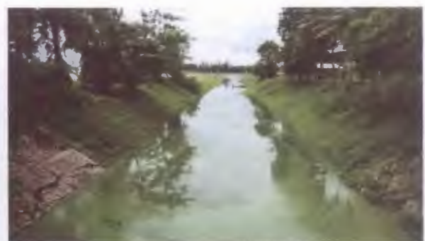
คลองชักน้ำ เขื่อนห้วยหลวง จังหวัดอุดรธานี
