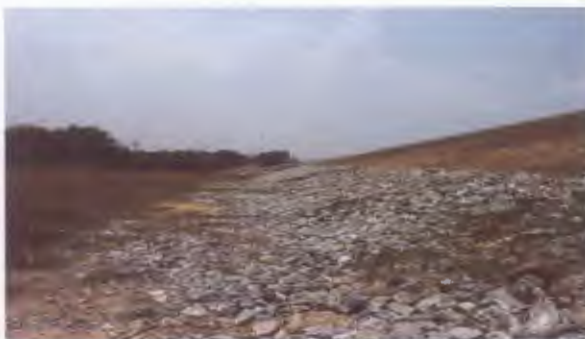
Contact Drain เขื่อนลำปาว จังหวัดกาฬสินธุ์
