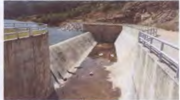
ฝายคอนกรีต พื่น และกำแพง เขื่อนบางเหนียวดำ จังหวัดภูเก็ต
