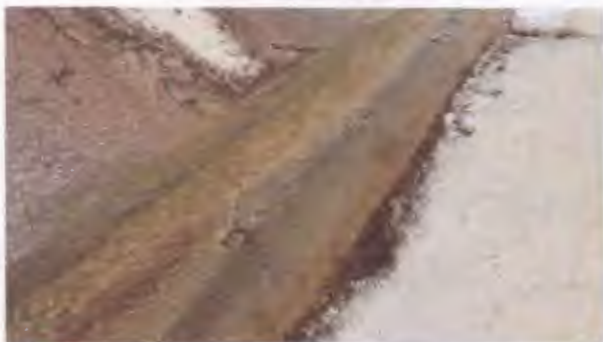
ระดับ 3 น้ำไหลมีตะกอน แต่ไม่เกิดการอุดตัน
