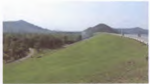
ลาดเขื่อนท้ายน้ำ เขื่อนปราณบุรี จังหวัดประจวบคีรีขันธ์
