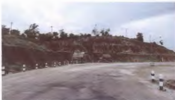
ฐานยันเขื่อนแบบเห็นไหล่เขา เขื่อนก๊วกคองหมา จังหวัดลำปาง
