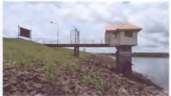
อาคารคอนกรีต เขื่อนลำนางรอง จังหวัดบุรีรัมย์
