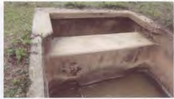
ส่วนสลายพลังงาน เขื่อนแม่เสี้ยงพัฒนา จังหวัดลำปาง
