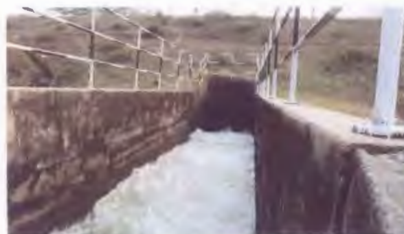
ภาพที่ 29 ส่วนทางน้ำออก อาคารท่อส่งน้ำ/อาคารท่อระบายน้ำ
