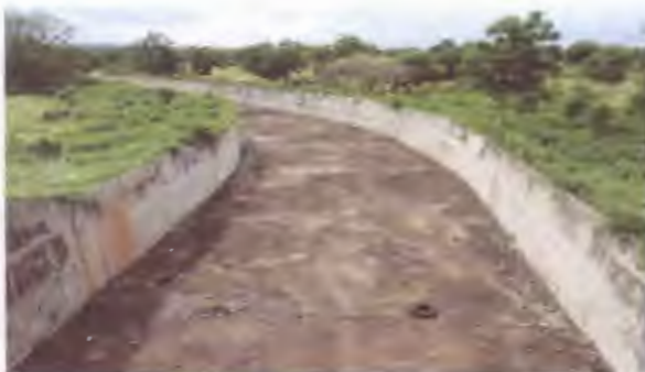
รางเท (Chute) เขื่อนลำนางรอน จังหวัดบุรีรัมย์
