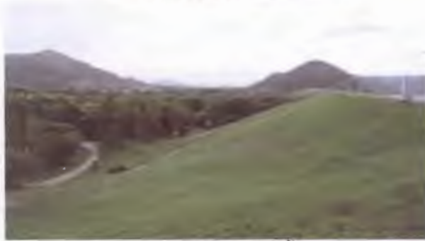
ระดับ 5 ไม่เกิดร่องน้ำ
