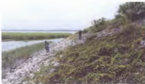
ภาพที่ 22 ตัวอย่างการตรวจสอบสภาพลาดเขื่อน
