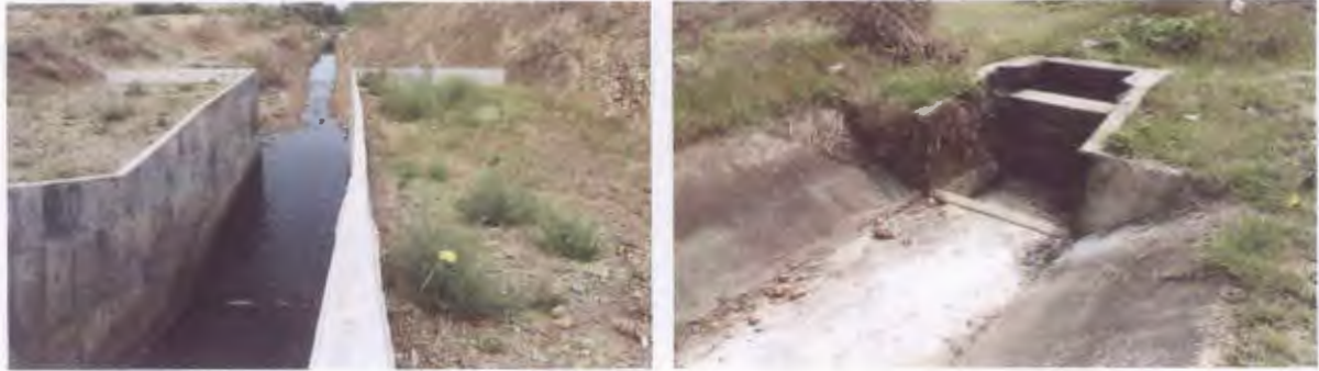
ภาพที่ 30 ส่วนสลายพลังงาน อาคารท่อน้ำ/อาคารท่อระบายน้ำ
