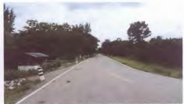
ฐานยันเขื่อน เขื่อนห้วยหลวง จังหวัดอุดรธานี
