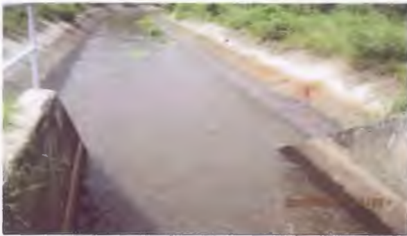
คลองส่งน้ำ/คลองระบายน้ำ เขื่อนลำนางรอง จังหวัดบุรีรัมย์
