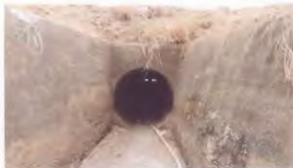
ภาพที่ 29 ส่วนท่อลำเลียงน้ำ อาคารท่อส่งน้ำ/อาคารท่อระบายน้ำ
