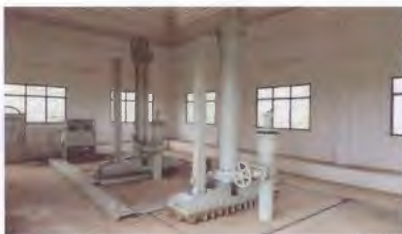
Guard and Operating Gates เขื่อนก๊วกอหมา จังหวัดระยอง
