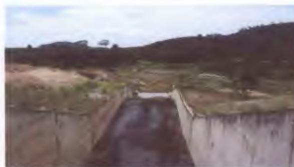
ส่วนทางน้ำออก เขื่อนป่าบอน จังหวัดพัทลุง
