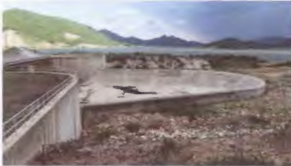
ฝายคอนกรีต พื่น และกำแพง เขื่อนห้วยผาก จังหวัดเพชรบุรี
