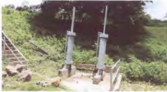
Guard and Operating Gates เขื่อนลำพระเพลิง จังหวัดนครราชสีมา
