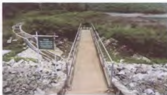
สะพาน (Access Bridge) เขื่อนแม่ออน จังหวัดเชียงใหม่
