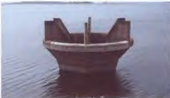
ฝาย คลیبและท่อตั้ง เขื่อนน้ำอูน จังหวัดสกลนคร
