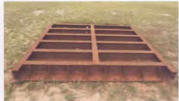
ภาพที่ 28 ประตูกันน้ำ (Bulkhead gate)
