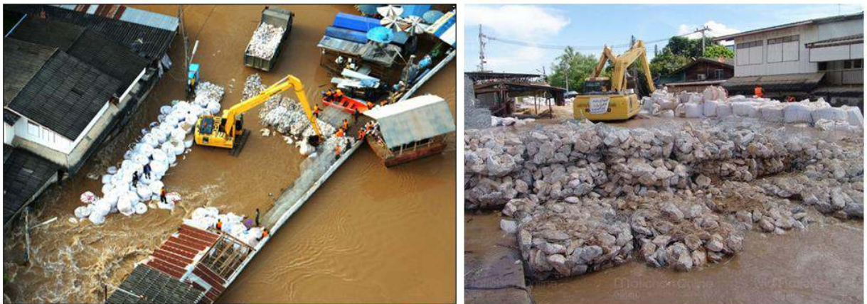
รูปที่ 5-9 การดำเนินการใช้กล่องลวดตาข่ายภายในบรรจุหินใหญ่ (Gabions) ปิดล้อมพื้นที่
