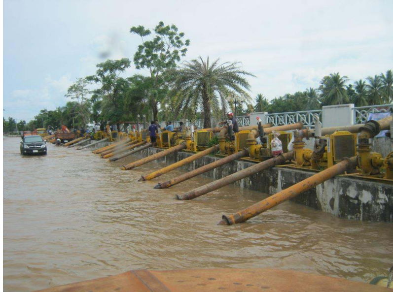
รูปที่ 7-6 แสดงการสูบน้ำออกจากบริเวณพื้นที่น้ำท่วมขังลงสู่แม่น้ำยม
