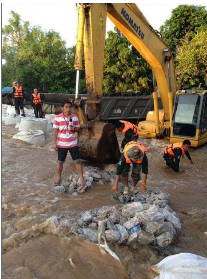
รูปที่ 7-2 กำลังพลจากกองทัพนาคที่ 3 ดำเนินการวางกล่องลวดตาข่ายภายในบรจุหินใหญ่ (Gabions)
