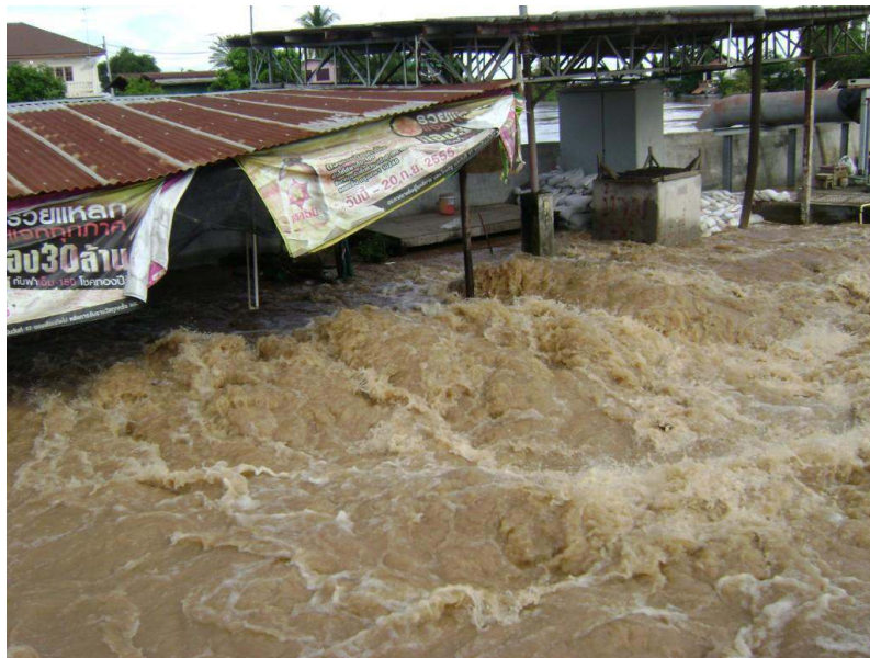
รูปที่ 7-1 บริเวณจุดที่เกิดน้ำผุดลอดใต้แผ่นพื้นคอนกรีตด้านหลังกำแพงป้องกันตลิ่งแม่น้ำยม
