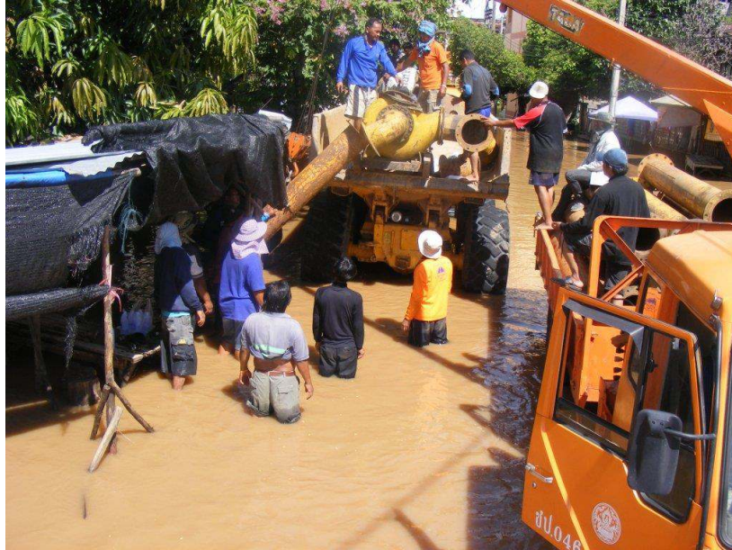
รูปที่ 7-8 การระดมติดตั้งเครื่องสูบน้ำเพื่อเร่งลดพื้นที่น้ำท่วมขัง
