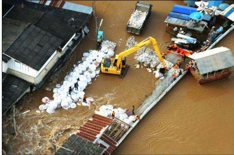
รูปที่ 7-3 ภาพมุมสูงแสดงให้เห็นแนวที่วางกล่องลวดตาข่ายภายในบรรจุหินใหญ่ (Gabions)
