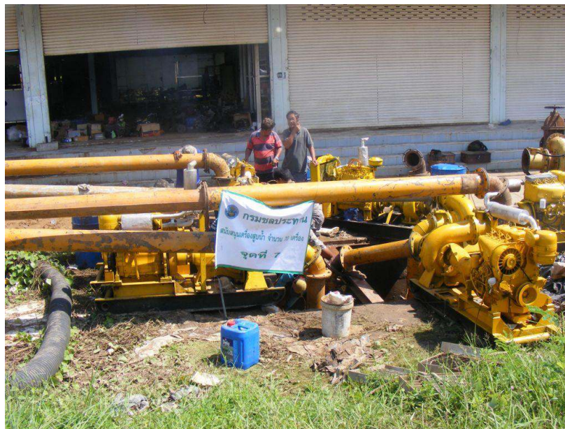
รูปที่ 7-5 กรมชลประทานได้ดำเนินการติดตั้งเครื่องสูบน้ำตามจุดต่าง ๆ
