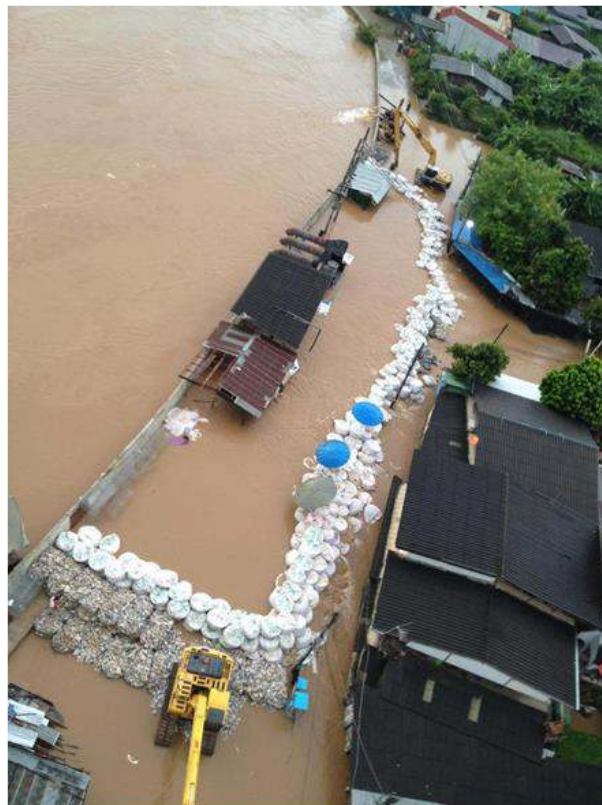
รูปที่ 5-11 สภาพการปิดล้อมพื้นที่ยกกระดับน้ำจนเท่ากับระดับน้ำด้านนอกกำแพง ทำให้น้ำไม่ไหลเข้ามาเพิ่มเติมบริเวณพื้นที่น้ำท่วมขัง
