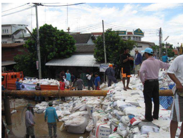
รูปที่ 8-2 หลังจากสามารถควบคุมน้ำไม่ให้ไหลเข้าได้แล้ว เร่งดำเนินการสูบน้ำด้านนอกคันออกทันที
