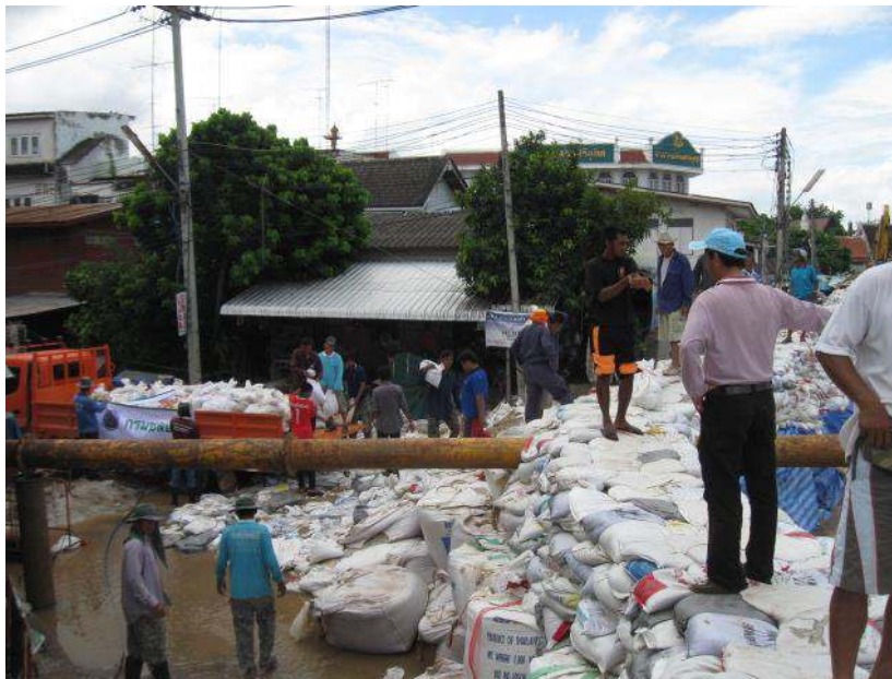
รูปที่ 7-9 กรมชลประทานดำเนินการสูบน้ำด้านนอกคันกั้นน้ำที่โอบล้อมปิดจุดที่เกิดน้ำมูลลงสู่แม่น้ำยม
